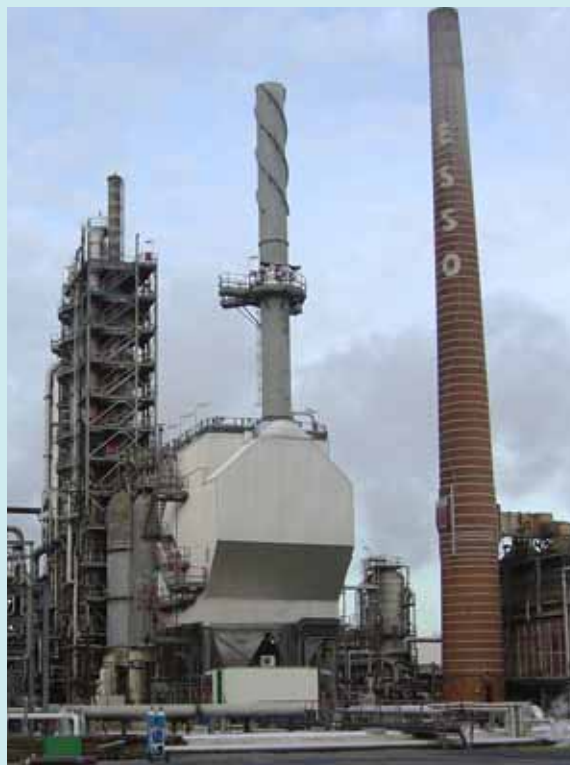
Electrofiltre installé dans une raffinerie de pétrole à Anvers, Belgique
