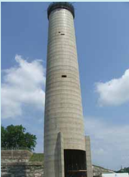
Construction d'une cheminée en béton, USA (vue d'ensemble)
