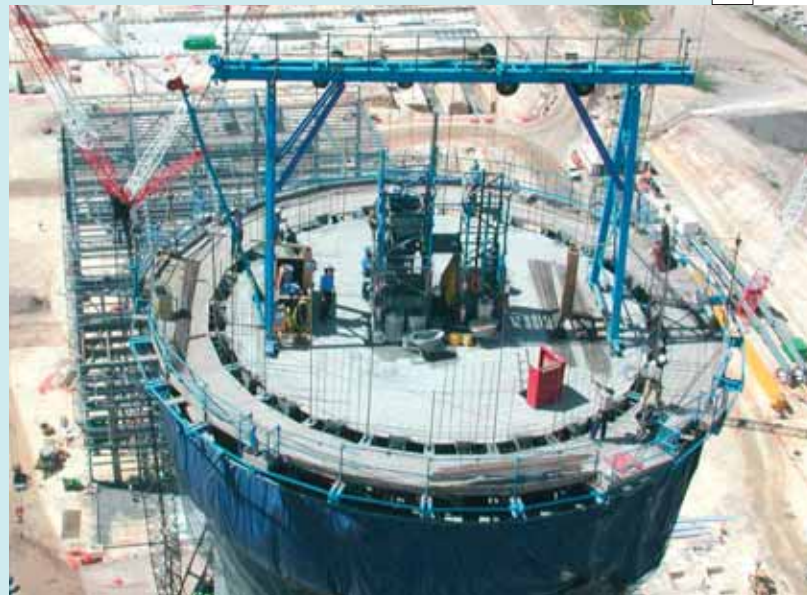
Plate-forme supérieure d'un échaffaudage glissant
